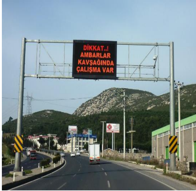
Şekil 1. Baş üstü direğe monte edilmiş DMİ (VMS mounted on overhead sign bridges)
